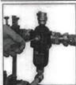
4.- Volver a colocar los imanes con el separador de plástico entre los imanes y el termómetro.
