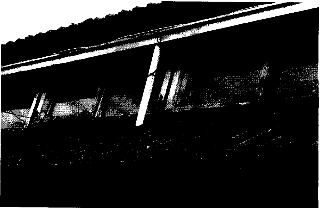
Estado de las aberturas.
