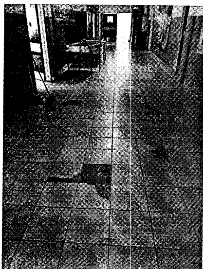
REPOSICION DE PISOS CIRCULACIONES.
