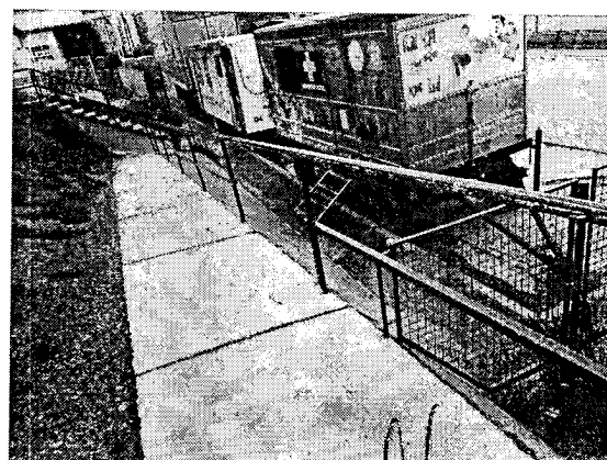
MEJORAMIENTO SECTOR DE RAMPA Y ESCALERA DE INGRESO.
