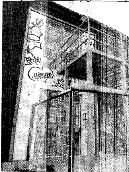
Salida de emergencia en planta alta
