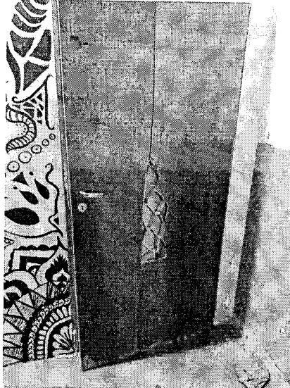
Recambio de puertas internas.
