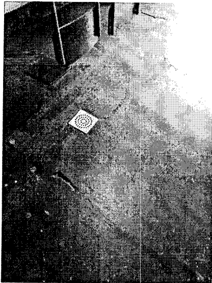
Pintura para piso y reparación.
